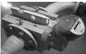
Posición de montaje horizontal
